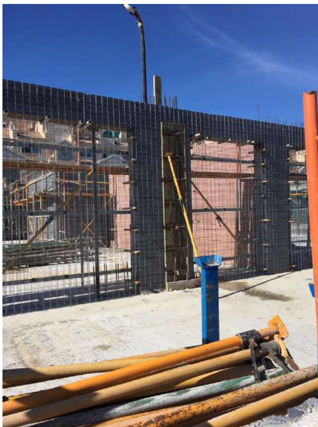
Refuerzo de pilar embebido en muro.
